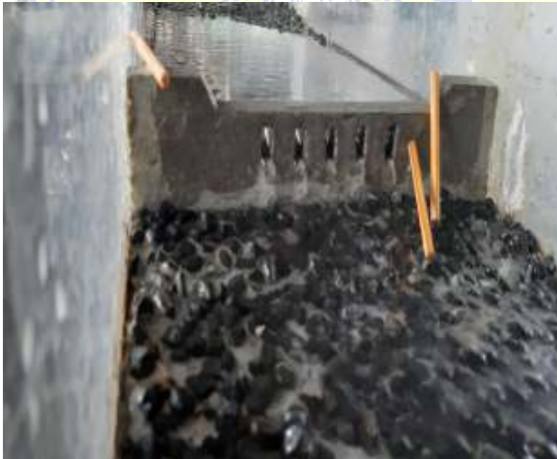
Kayu tertahan di Sabo Dam
