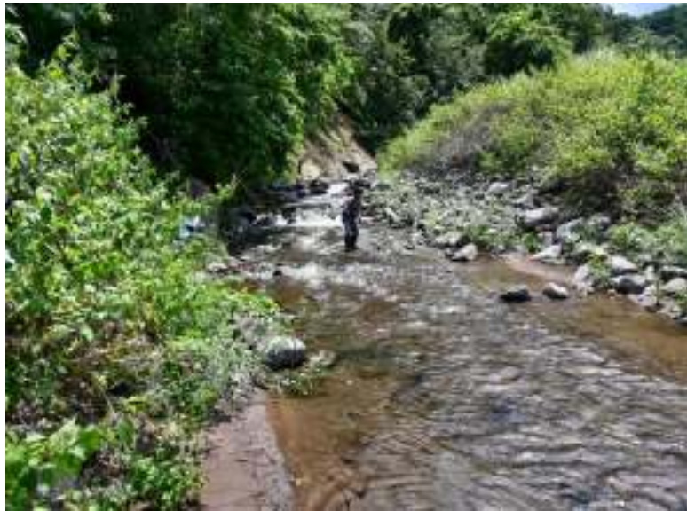
Aliran Air di Hulu Sabo Dam
