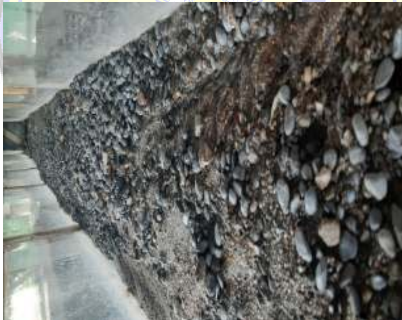
Perubahan Elevasi dasar akibat banjir
