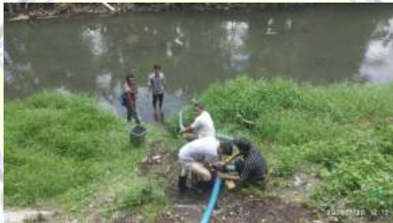
Menyalan mesin pompa air untuk mengaliri air pada flume
