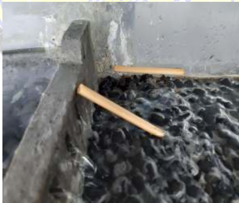
Kayu tertahan di sabo dam
