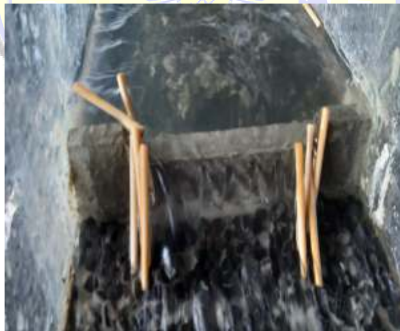
Kayu tertahan di sabo dam
