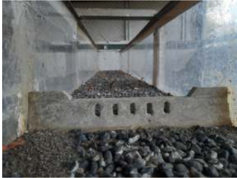
Memasang sabo dam pada flume
