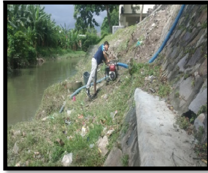
Gambar 3.17 Menghidupkan Pompa Air
