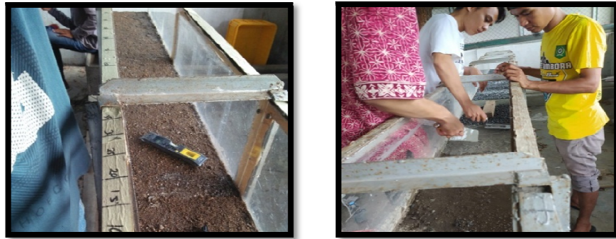
Gambar 3.4 Dasar Tetap Flume, (a) Proses Persiapan dan (b) Proses Pemasangan.
