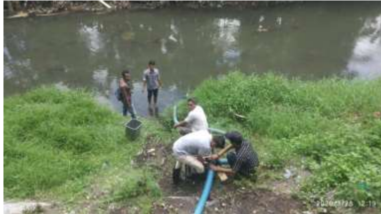
Menyalan mesin pompa untuk mengalir air pada flume
