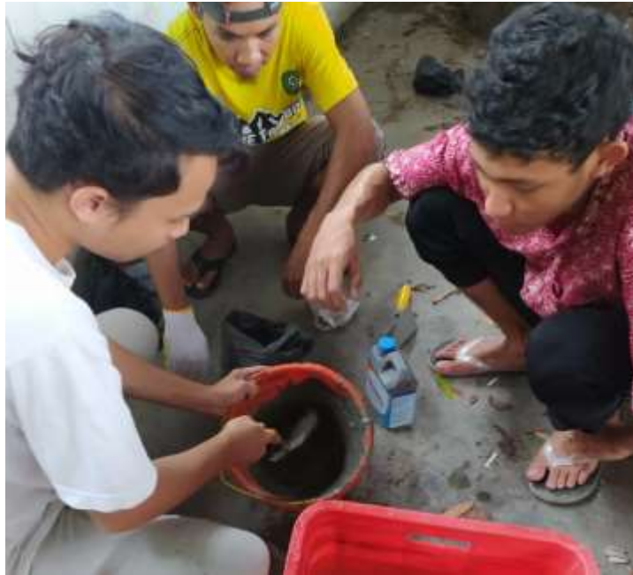
Mencampur perekat untuk dasar tetap sabodam (semen dan damdex)
