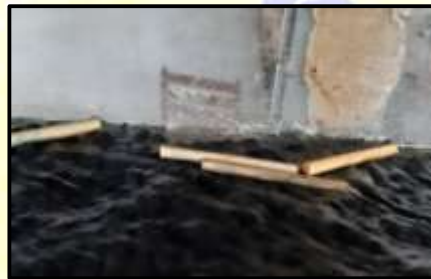
Gambar 3.23 Kayu yang Tertinggal di Dinding flume
