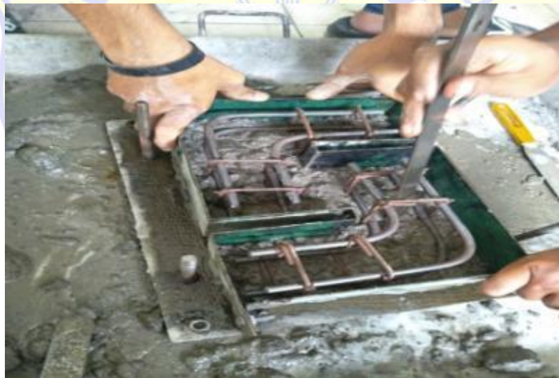
PENGISIAN BETON SEGAR PADA CETAKAN
