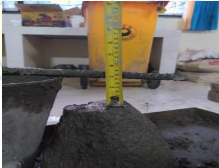
PEMERIKSAAN NILAI SLUMP BETON SEGAR
