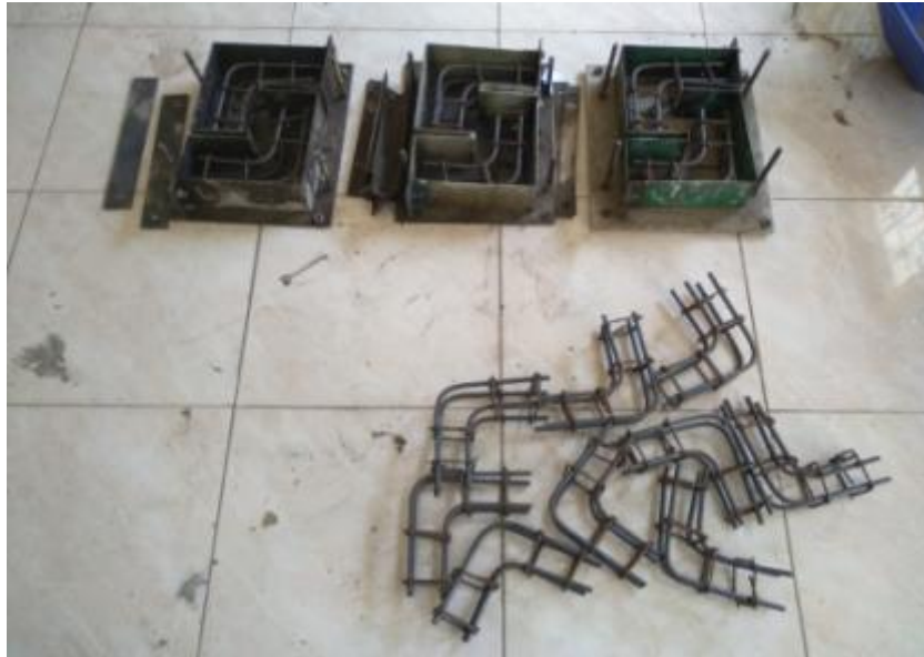
PERSIAPAN CETAKAN DAN TULANGAN DOUBLE-L
