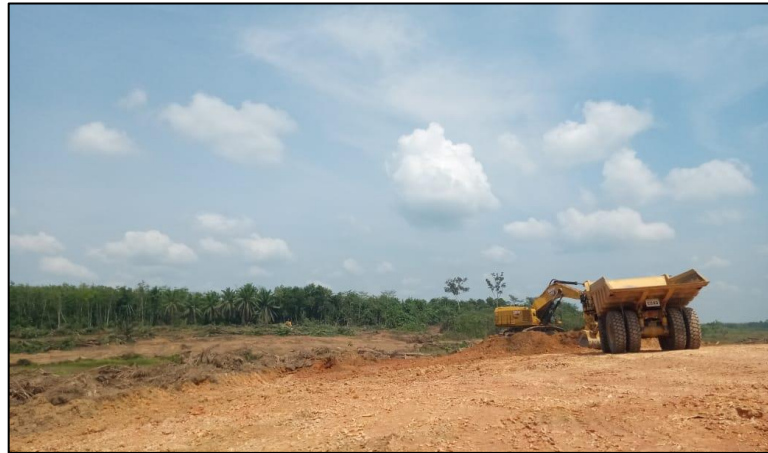
Gambar 2.7 Land Clearing Wilayah Timur Pit Wara (Sumber : Dokumentasi Penulis, 2023)
