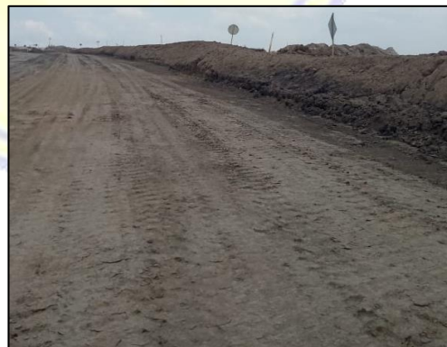
Gambar 4.4 Corrugated sesudah perbaikan (Sumber : Penulis, 2023)
