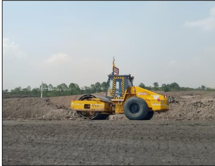
Gambar 3.4 Perbaikan Permukaan Jalan (Sumber : Penulis,2023)
