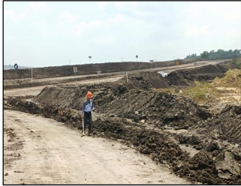
Gambar 4.1 Drainase sebelum perbaikan (Sumber : Penulis, 2023)
