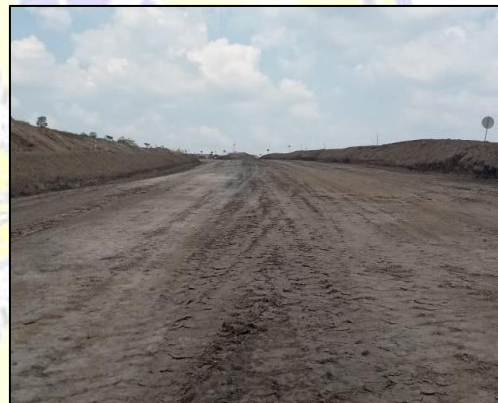
Gambar 4.6 Rutting sesudah perbaikan (Sumber : Penulis, 2023)
