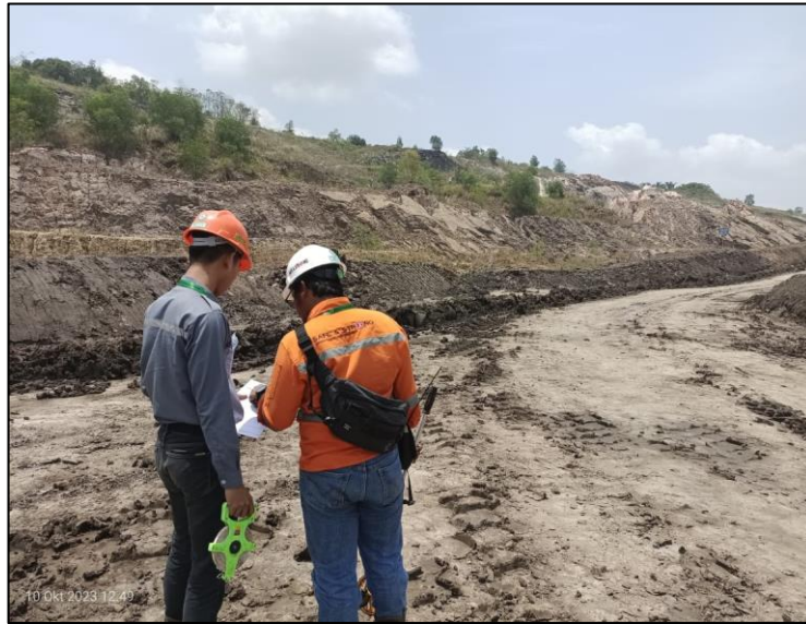
Gambar 3.3 Inspeksi Nilai URCI Pada Jalan Hauling Road Brazil Low Wall (Sumber : Penulis,2023)
