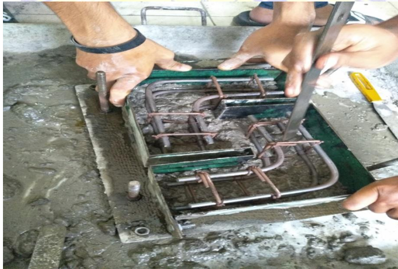
PENGISIAN BETON SEGAR PADA CETAKAN
