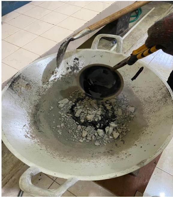
Gambar 5. Penuangan Aspal ke Agregat
