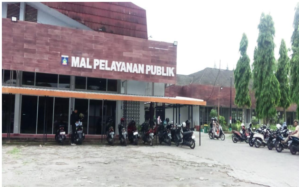
Gambar 5.5 Gedung MPP Tampak Depan
