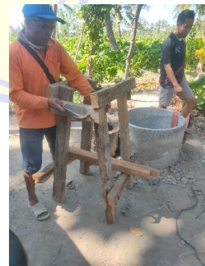
Pembuatan Dudukan Pompa
