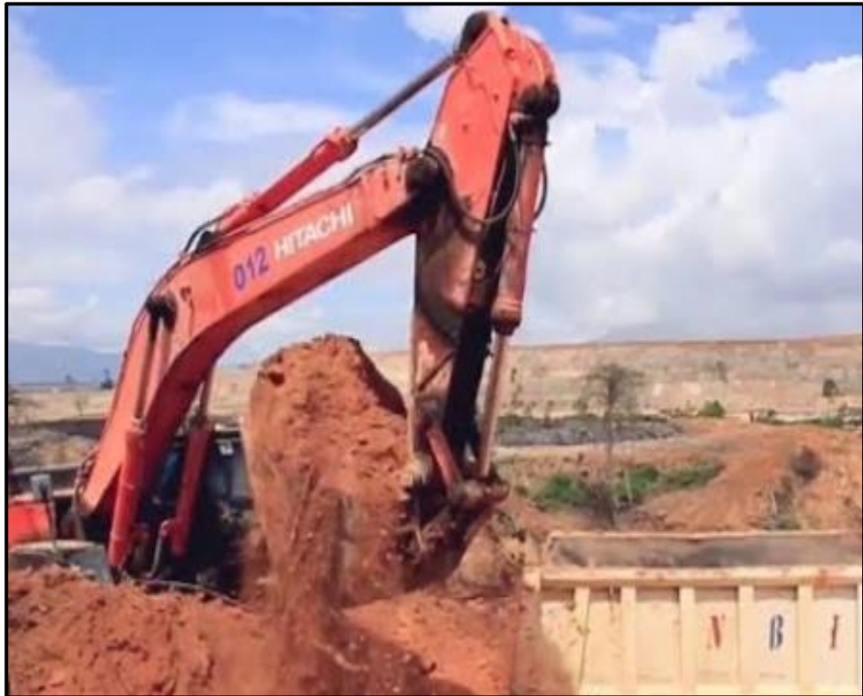
Gambar 2. 9 Pengupasan Top soil (Sumber: Dokumentasi Pribadi,2023)
