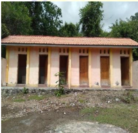
Gambar : Kamar Mandi/Toilet
