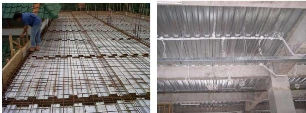
Gambar 2.3 Pengerjaan Plat Bondek
