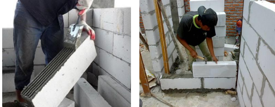
Gambar 2.6 Pengerjaan Pasangan Bata Ringan
