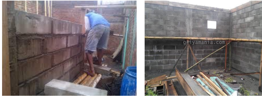
Gambar 2. 5 Pengerjaan Pasangan Batako
