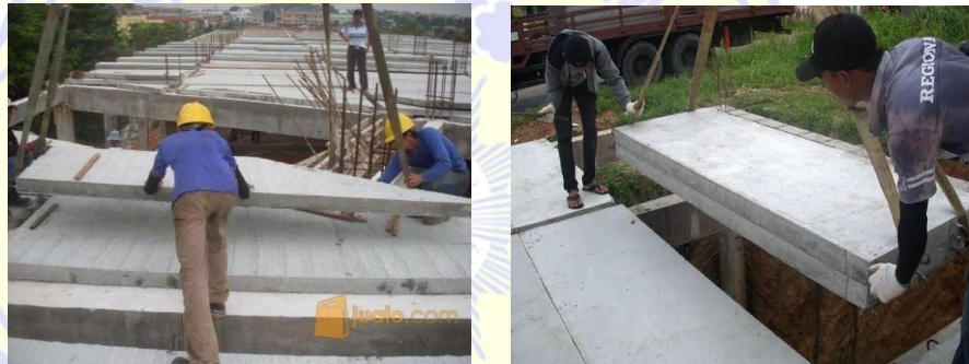
Gambar 2.2 Pekerjaan Plat Precast
