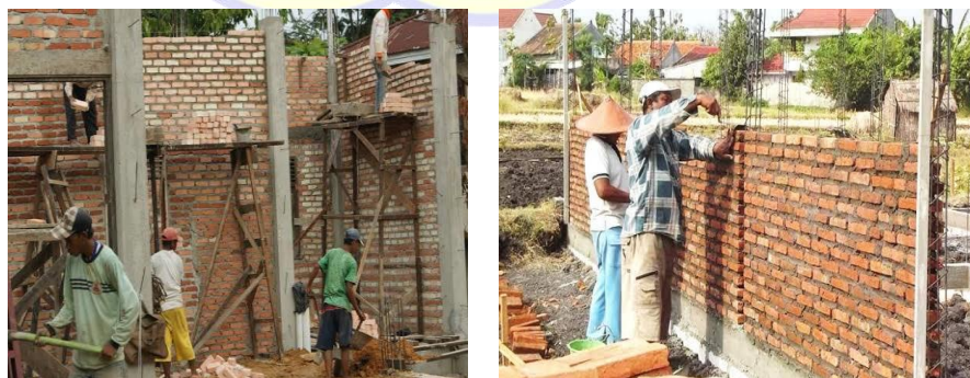
Gambar 2.4 Pekerjaan Pasangan Dinding Bata Merah
