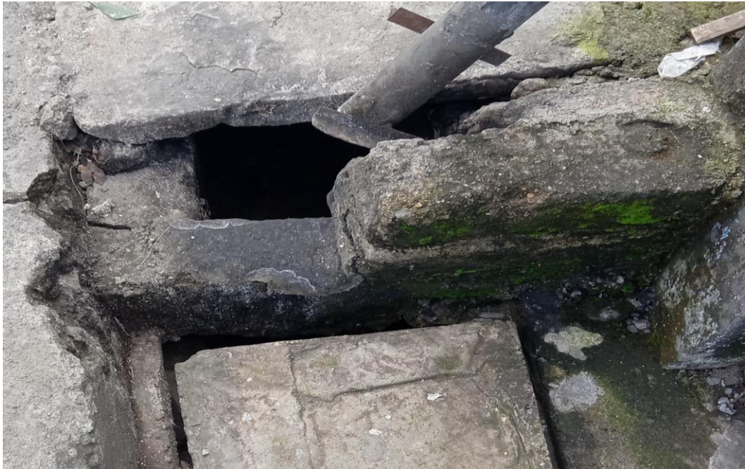
Bentuk drain hole pada saluran tertutup
