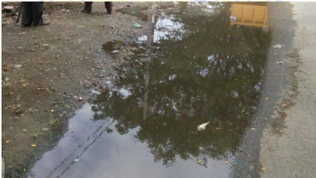
Genangan pada bahu jalan
