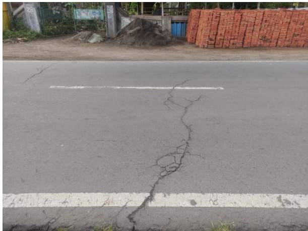
Gambar Retak Memanjang dan Melintang
