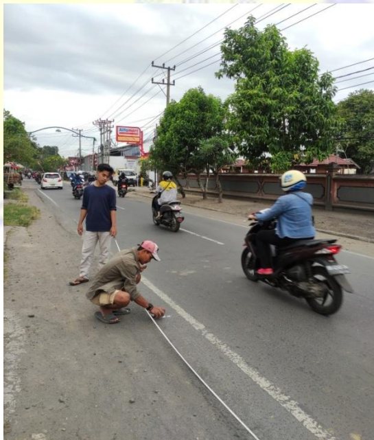
Gambar Pengukuran Panjang Jalan dan Pengecatan Patok Sta
