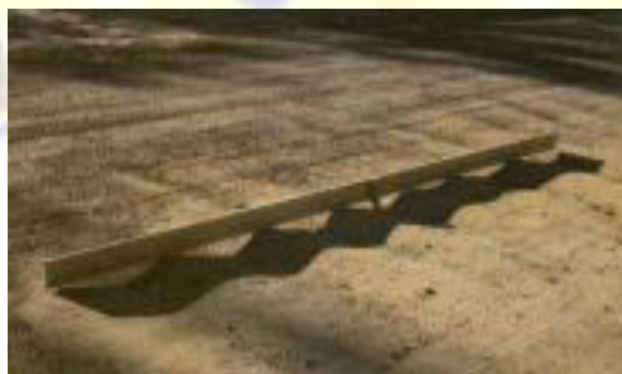
Gambar 2.16. Retak Keriting ( Corrugation ).
