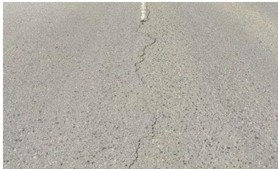
Gambar 2.6. Retak Memanjang
