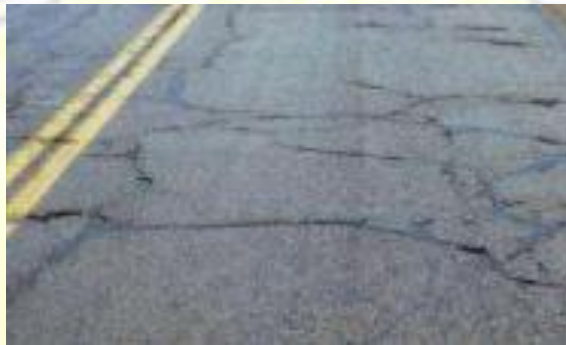
Gambar 2.12. Retak Kotak ( Block Cracking ).
