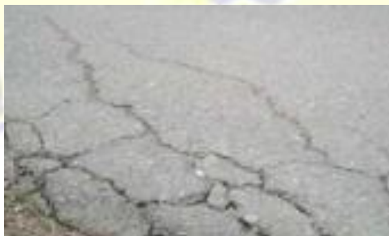
Gambar 2.8. Retak Pinggir.
