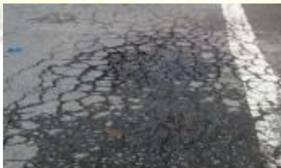
Gambar 2.2. Retak Kulit Buaya.
