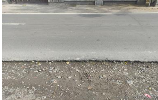
Gambar 2.30. Penurunan Pada Bahu Jalan.
