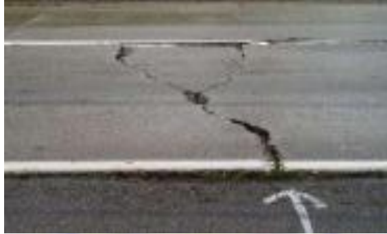
Gambar 2.10. Retak Sambungan Bahu Perkerasan.
