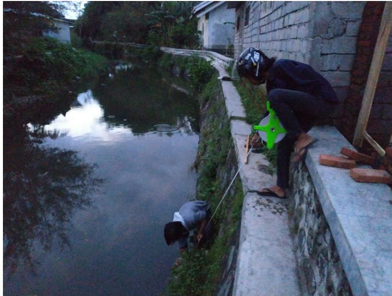
Tinggi penampang eksisting sungai Leneng
