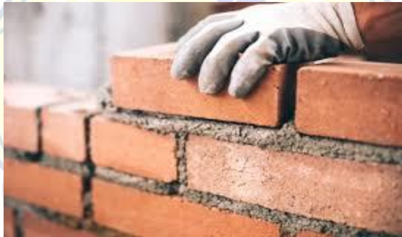
Gambar 2.1 proses pemasangan bata merah
