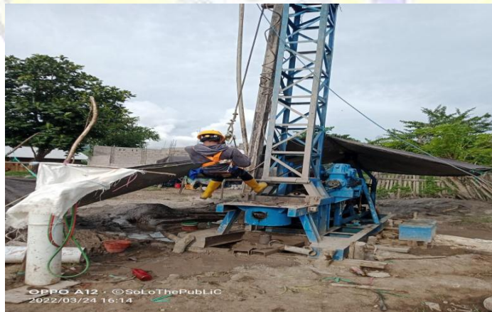
Gambar 6. 5 Penyambungan Stang Bor
