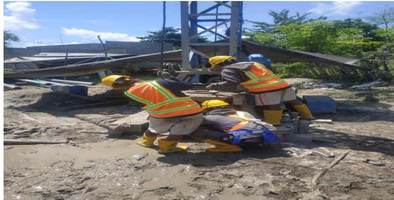
Gambar 6. 6 Pembersihan Lubang Bor
