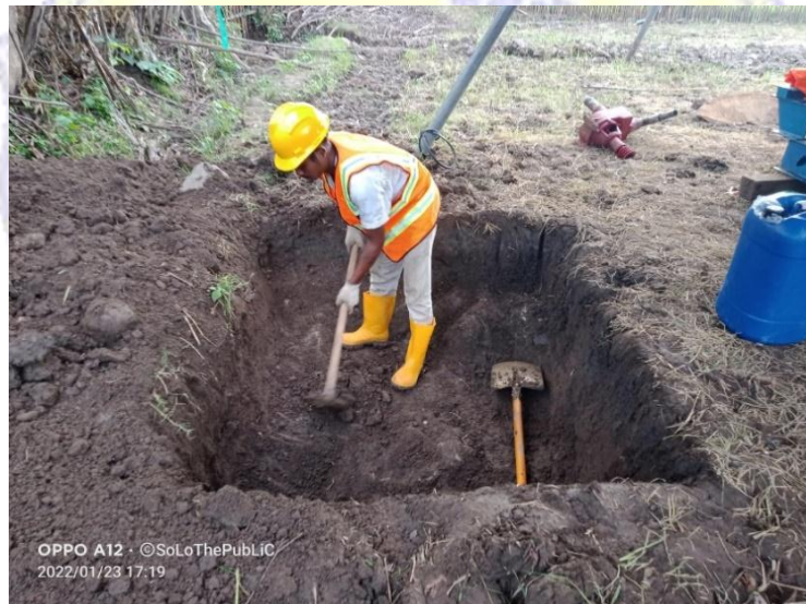
Gambar 6. 1 Pembuatan Bak sirkulasi
