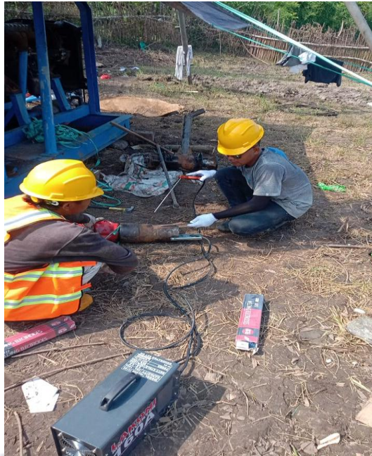
Gambar 6. 2 Pemasangan Mata Bor
