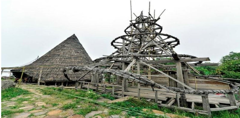
Gambar 4.2. Kegiatan bangunan infrastruktur Niang Todo
