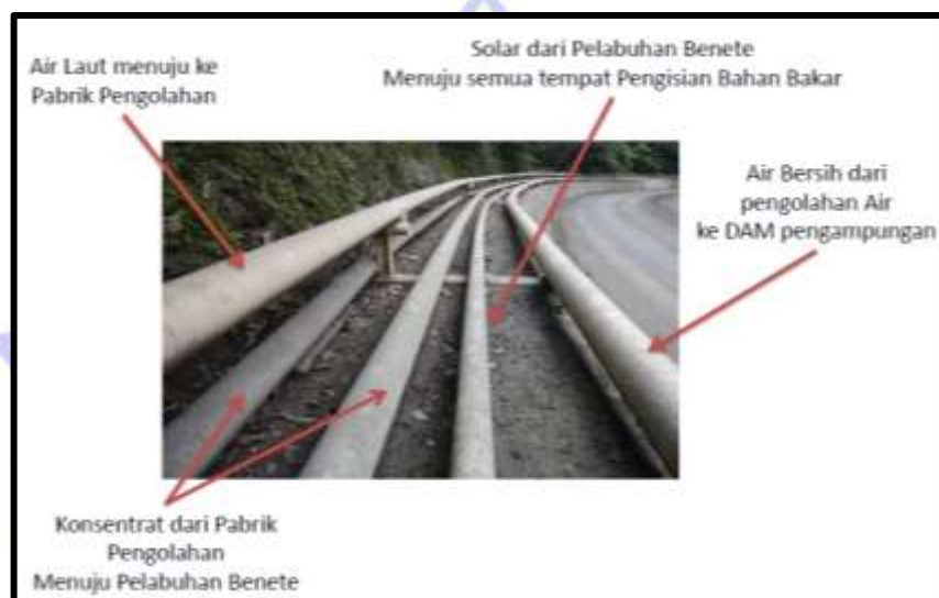
Gambar 15. Sistem Pipa untuk Pengangkutan dan Distribusi (Sumber: Dokumentasi Pribadi, 2019)
