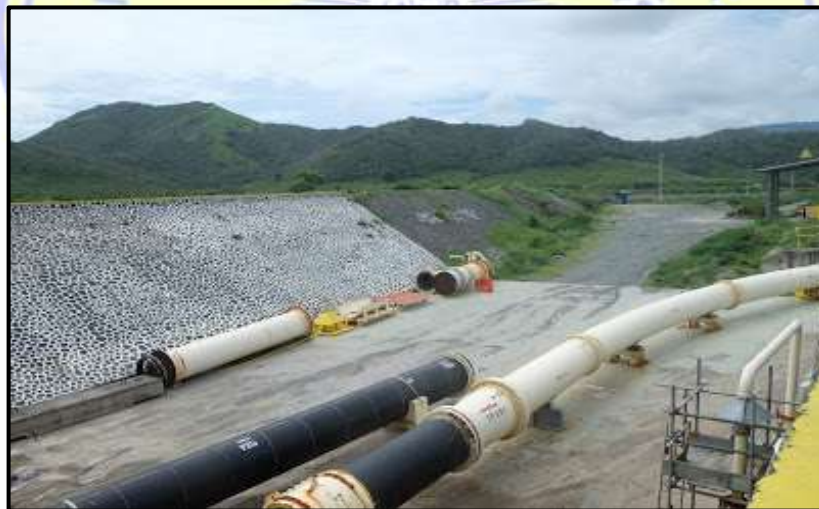
Gambar 19. Proses pembuangan tailing melalui pipa
