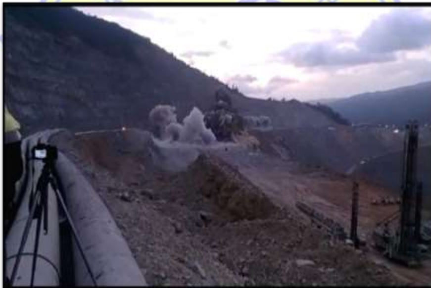
Gambar 11. Proses Peledakan di Pit Batu Hijau (Sumber: Dokumentasi Pribadi, 2019)
