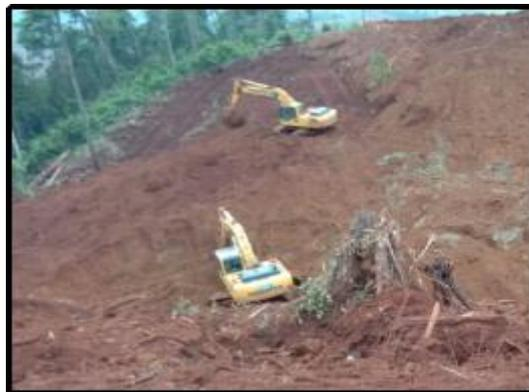
Gambar 2. 3Kegiatan Pengupasan Tanah Pucuk (*Top Soil Removal*)
