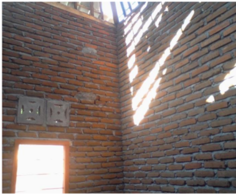
Gambar 13. Salah satu rumah warga di Kelurahan Jempong Baru tidak menggunakan kolom praktis
