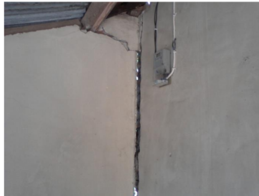
Gambar 14. Salah satu kerusakan yang terjadi pada rumah warga di Kelurahan Jempong Baru karena tidak menggunakan kolom praktis
