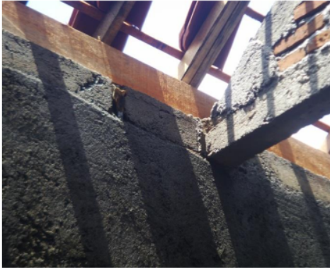
Gambar 8. Rumah salah satu warga Sekarbela “Amaq” menggunakan kuda-kuda beton
