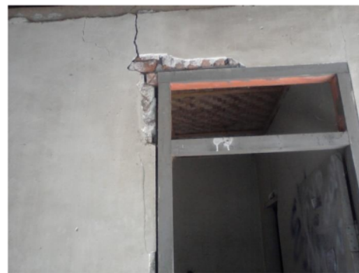
Gambar 11. Salah satu rumah warga Jempong Baru dinding pasangan bata tidak diangkur pada kusen
