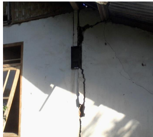
Gambar 16. Salah satu rumah warga Jempong Baru tidak menggunakan Balok ring dan kolom praktis
