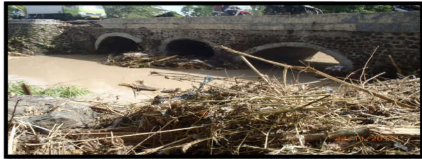
Gambar 3.1 Jembatan di lapangan
