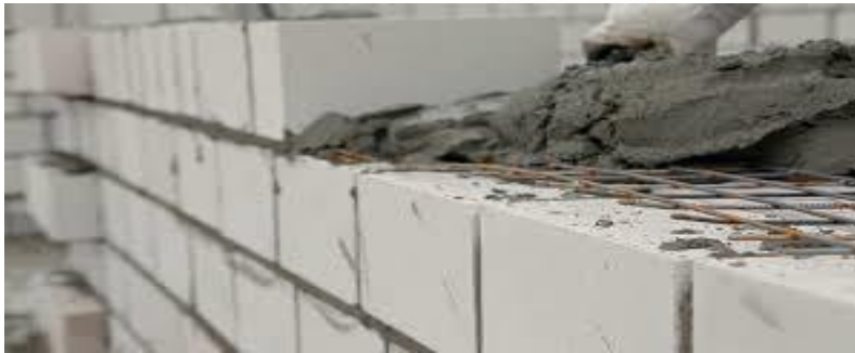
gambar 2.3 cara pemasangan acian bata ringan
