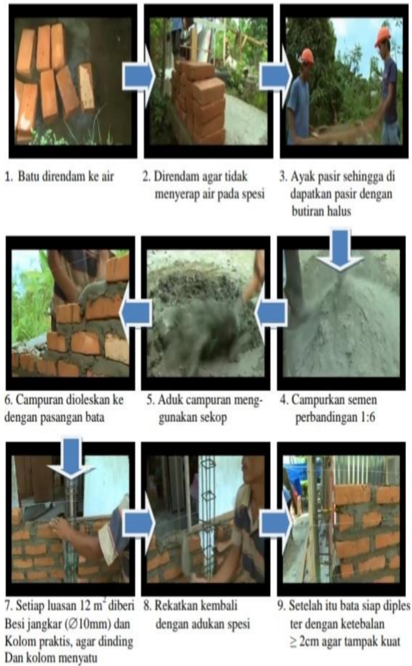
Gambar 2.2 tata cara pemasangan batu bata merah
