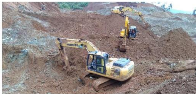
Kegiatan Penambangan Ore menggunakan Excavator Komatsu PC 200-8, Komatsu PC 300-8
