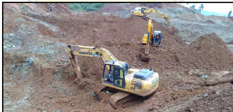
Gambar 2. 6 Kegiatan Penambangan Ore menggunakan Excavator Komatsu PC 200-8, Komatsu PC 300-8
