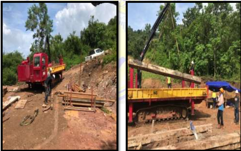
Gambar 2.3 Crane Truck PT Sumbawa Barat Mineral
