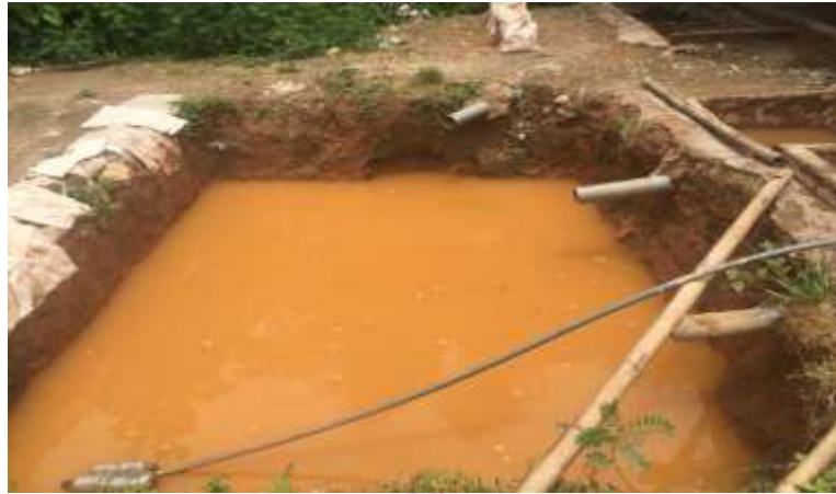
Gambar 9: Limbah Kedua Setelah Dilakukan Pembersihkan Limbah Pertama
