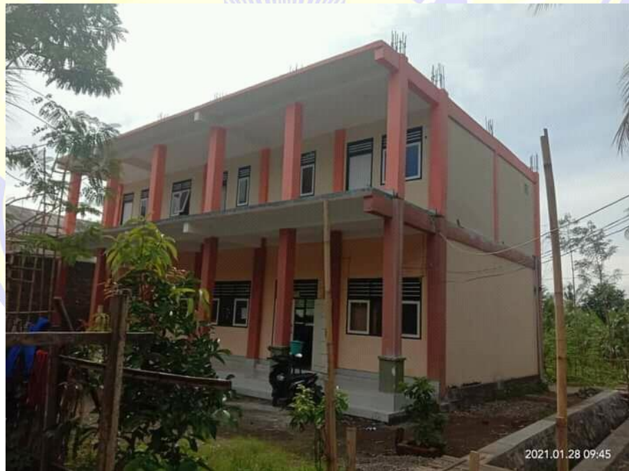
Gambar 6 kondisi kelas putra setelah direnovasi
