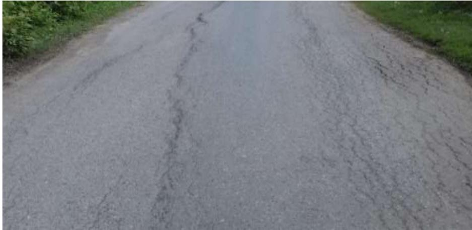
Gambar 1.1 Kerusakan perkerasan jalan yang bergelombang
