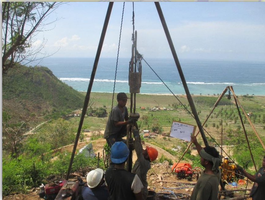
Uji N-SPT pada Pengeboran Geoteknik Kav.60 BH-1
