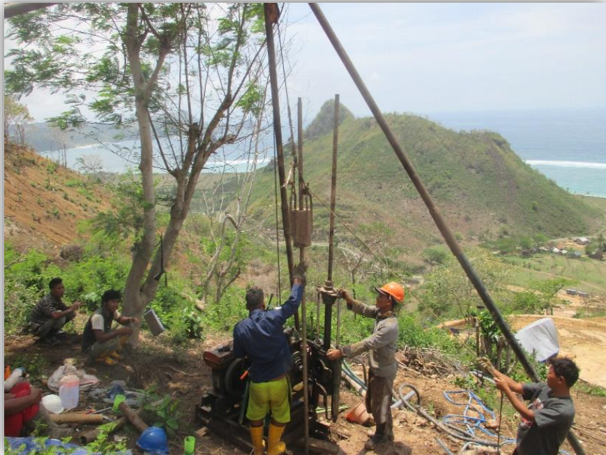
Uji N-SPT pada Pengeboran Geoteknik Kav.60 BH-1
