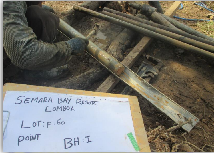
Gambar 3.2 Pengambilan sampel Pengeboran Geoteknik Kav.60 BH-
