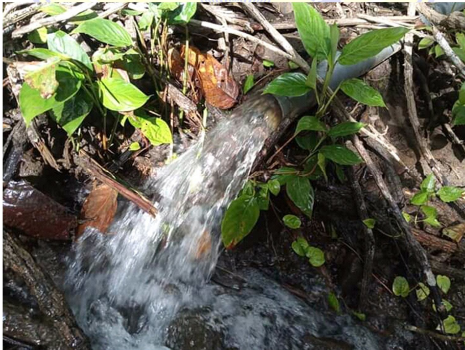
PERBAIKAN PIPA AIR BERIH
