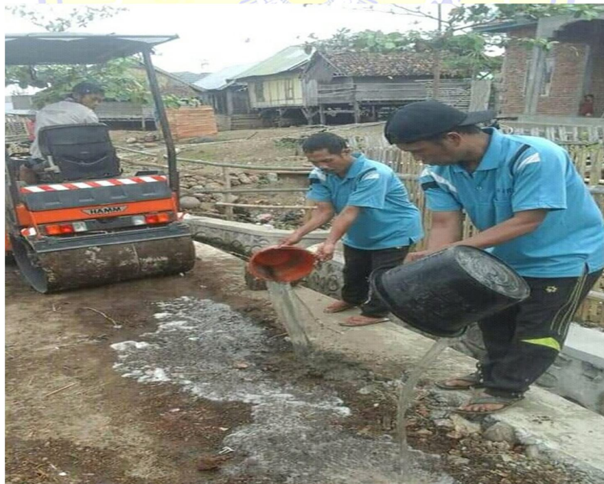
PENGASPALAN JALAN (GANG BARU)
