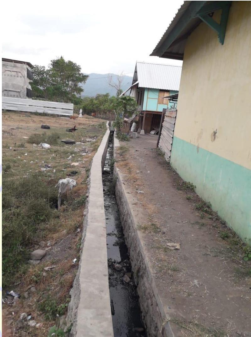
(foto contoh pembuatan talud di otak desa)
