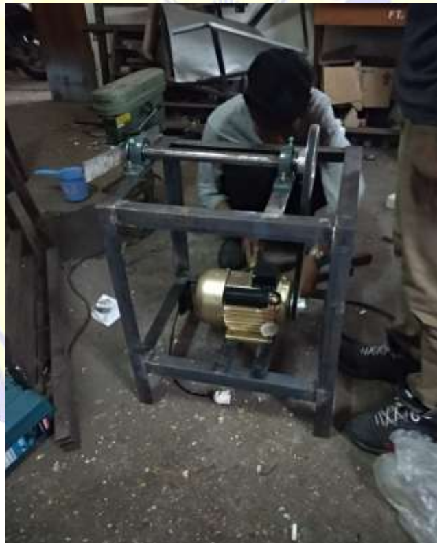
Lampiran 10. Proses pemasangan motor listrik.
